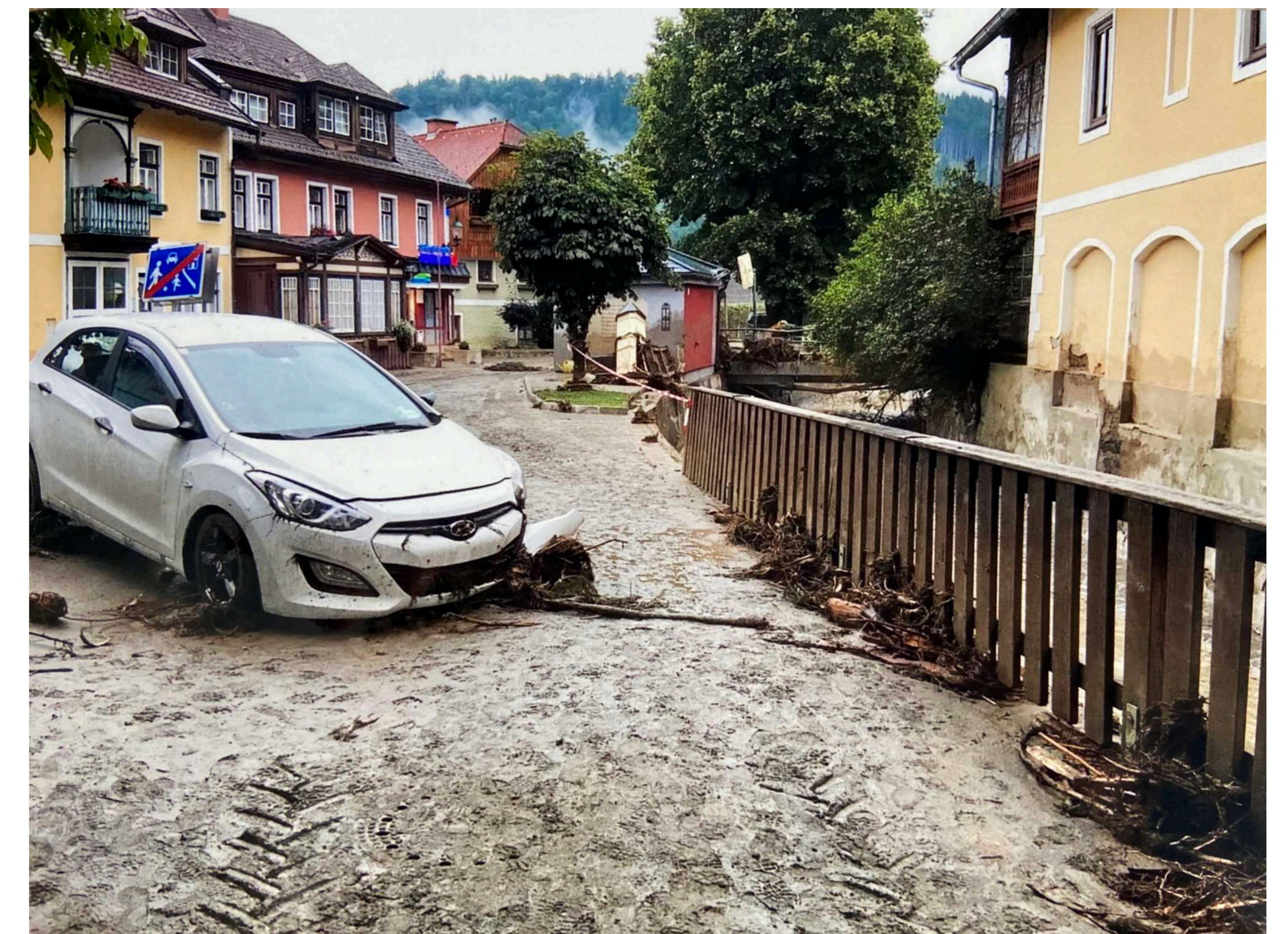
Der Weg Richtung Fischerbrücke nach der Unwetterkatastrophe im Jahr 2017, Bildquelle: Jakob Gruber aus „Hochwasser Öblarn“ von Thomas Reinbacher
